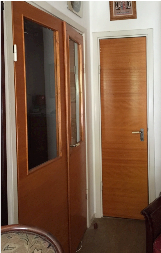
Ursprungliga och tidstypiska dörrar med björkfaner och dörrtrycken i bakelit. Snickerierna var vid denna tid släta.
