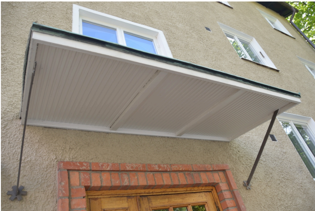
Skärmtakets undersida är klädd med panel. Lägg märke till infästningarnas blomform.
