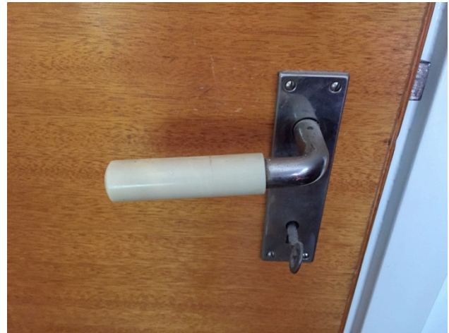
Ursprungliga och tidstypiska dörrar med björkfaner och dörrtrycken i bakelit. Snickerierna var vid denna tid släta.
