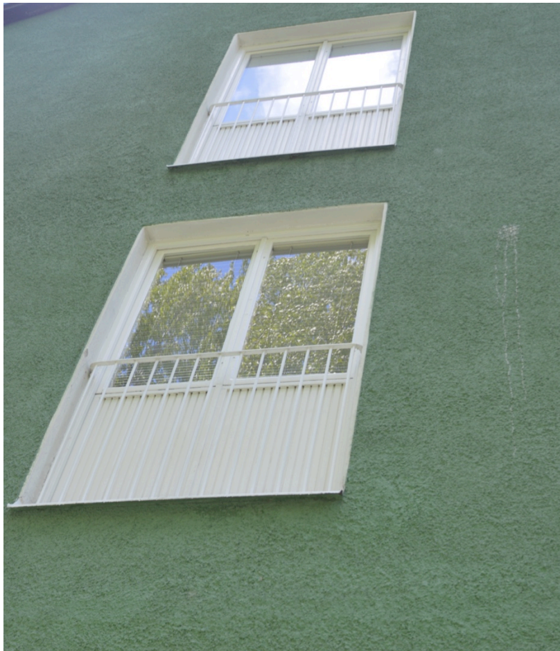
Franska balkonger med räcken i pinnsmide.
