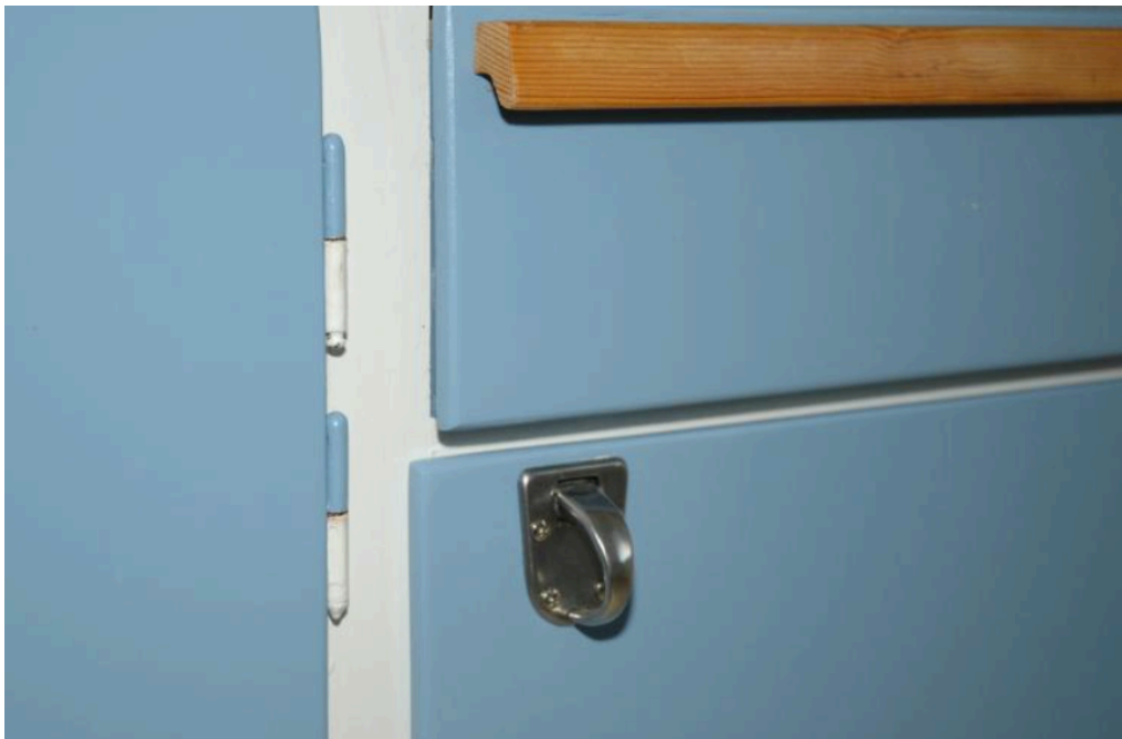
Så här har det sett ut i alla lägenheter från början. Pinngångjärn och det klassiska grip-handtaget på luckor i 1950-talskök. Intill syns även den trärena list som vanligen användes som handtag på lådor under 1940- och 1950-tal. Bilden kommer från Stadsmuseets arkiv.
