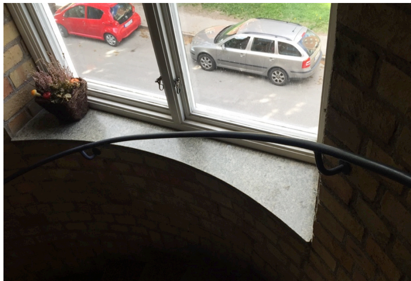
Trapphuset bevarar ursprungliga fönsterbänkar i kolmårdsmarmor och karaktärsskapande väggar i gult tegel. Lagg märke till fönstrets smäckra fönsterbågar och ursprungliga fönsterbeslag.
